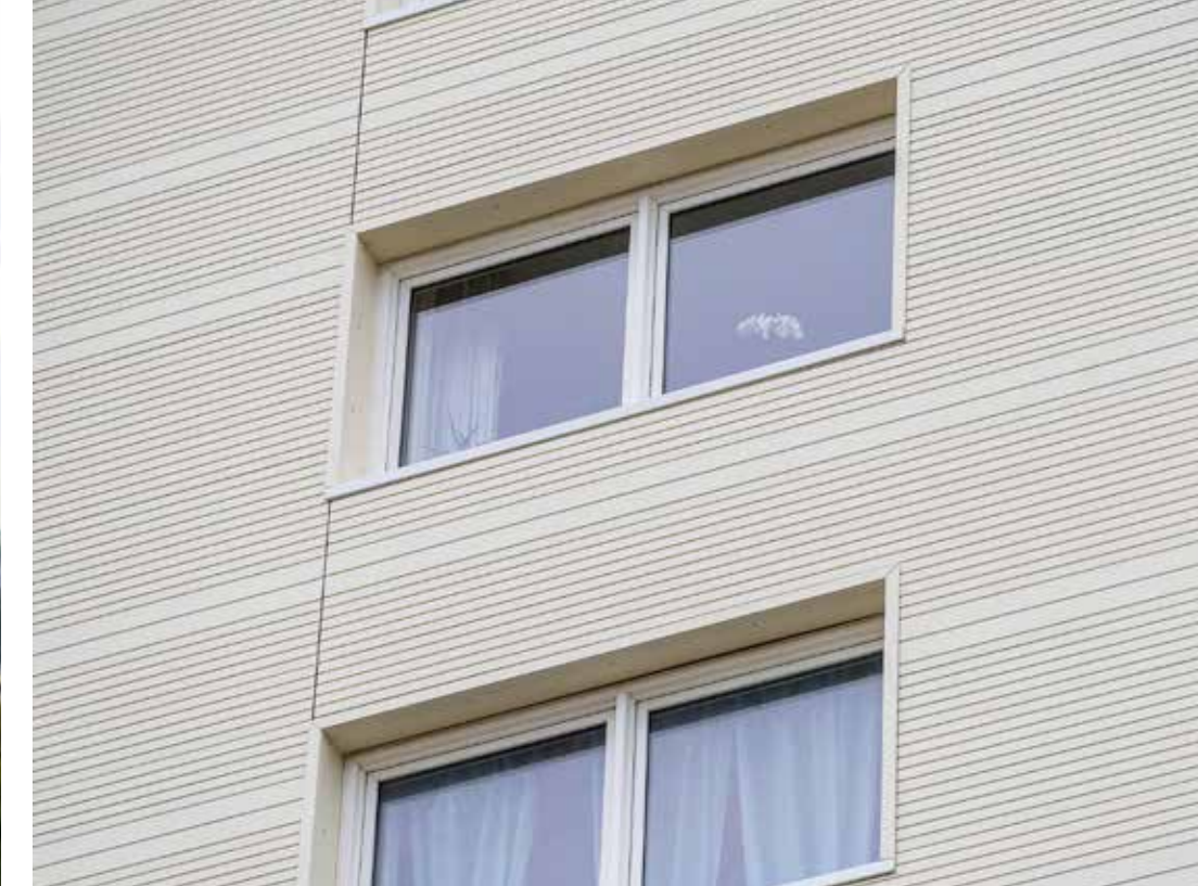
Afwerking rondom bestaande kozijnen.
