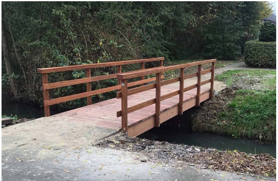
De eerste C2C-brug is gebouwd in Arnhem. (Foto's: Harrie Ligtoet)
