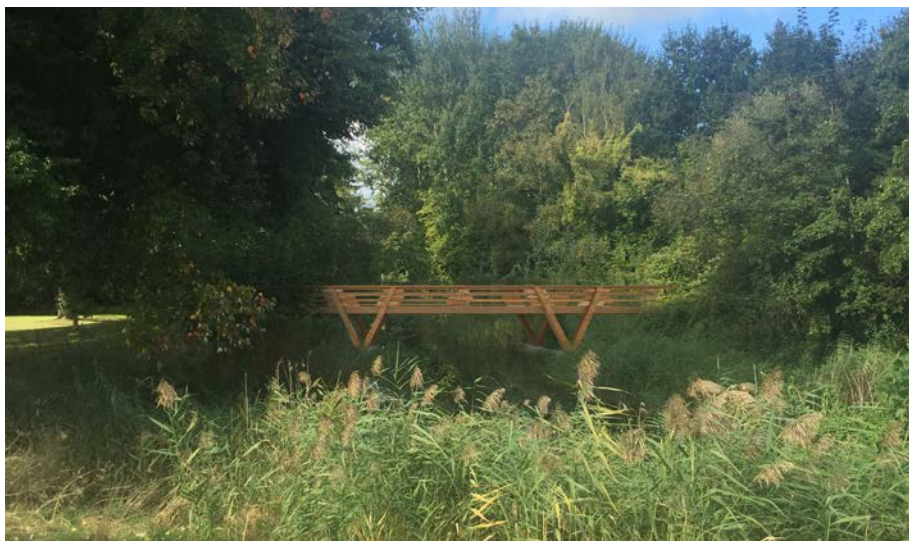
Deze 'Uitlaatbrug' in Almere wilde de gemeente eerst slopen. Actie van bewoners heeft dit voorkomen; hout is hergebruikt.
